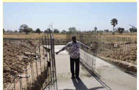
Justin sur l'un des 4 ouvrages
